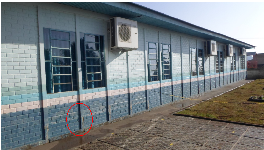
Foto 01 – Parte da fachada da escola em estrutura pré-moldada.
